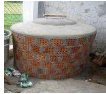
Hình 23. Bể bioga hộ gia đình
