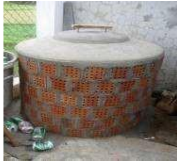
Hình 9. Bể bioga hộ gia đình
