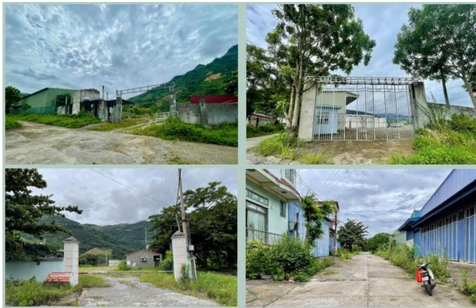
Ảnh 4: Hiện trạng công trình nhà xưởng, kho bãi
